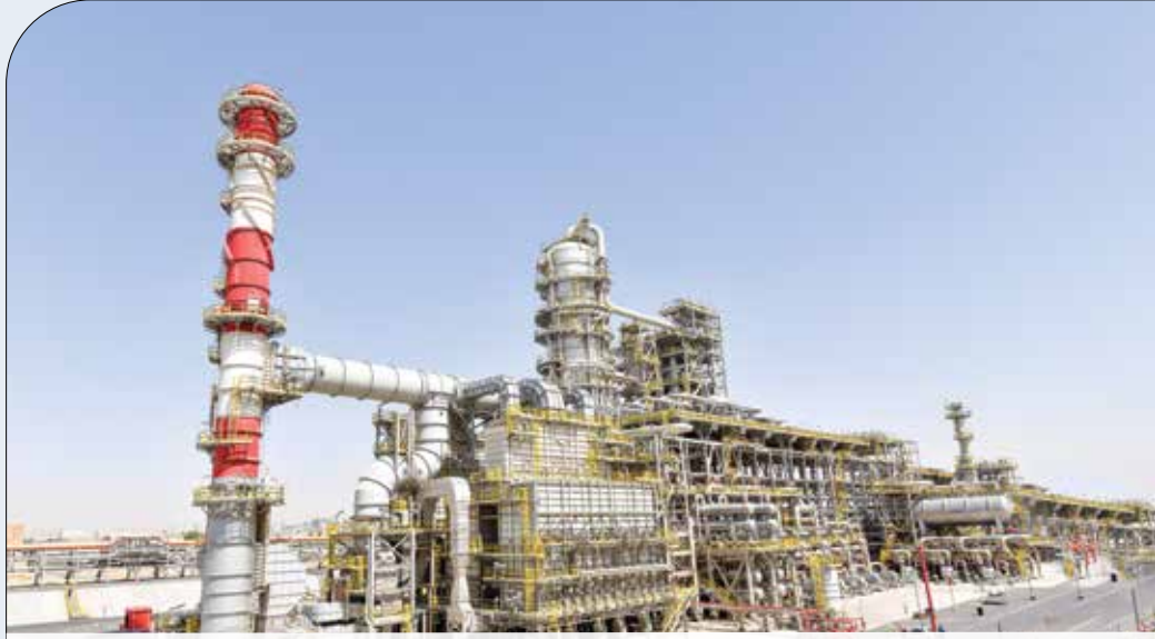
• وحدة تقطير النفط الخام (CDU-111) التي تستخدم في معالجة الديزل المستهلك
