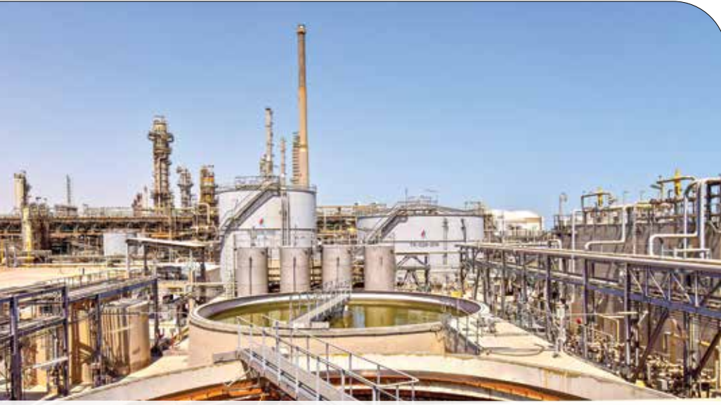
● وحدة معالجة مياه الصرف الصناعي في مصنع الغاز البترولي المسال (U-29)
