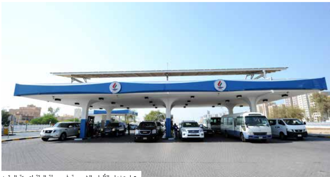
• استخدام الألواح الشمسية في محطة الرقة لتعبئة الوقود
