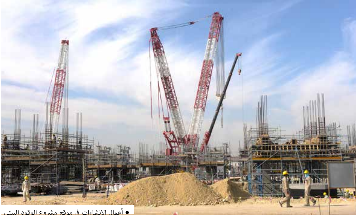
• أعمال الإنشاءات في موقع مشروع الوقود البيئي.
