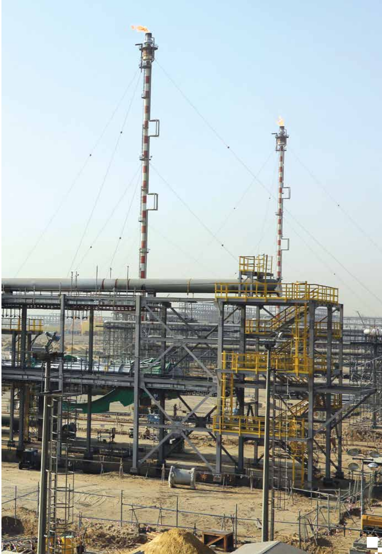
مشروع إنشاء وحدة استرجاع غاز الشعلة بمصفاة ميناء عبدالله
