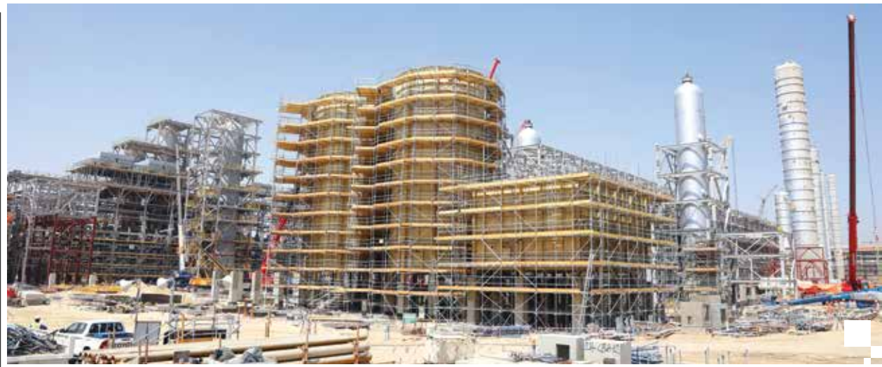
أعمال الإنشاءات في مشروع الوقود البيئي
