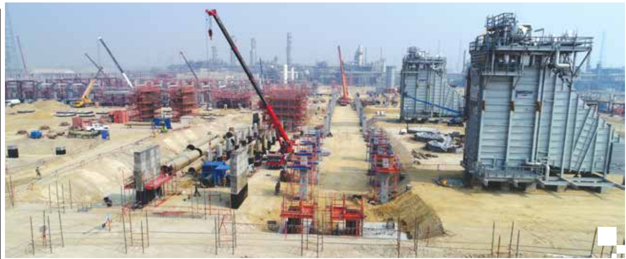
مشروع إنشاء وحدة خامسة لإنتاج غاز البترول المسال
